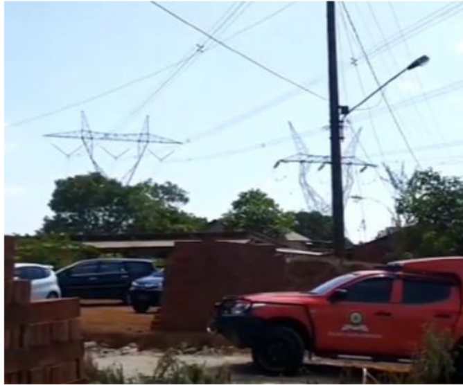
Gambar 2. Span tower 434 – 435, Konfigurasi Horizontal, dengan Tower Ganda
