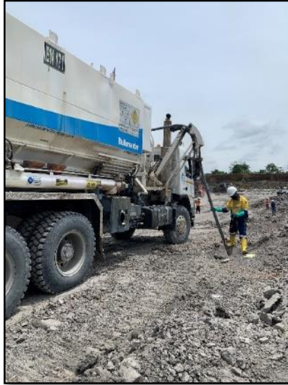
Gambar 4. 6 Charging Bahan Peledak
