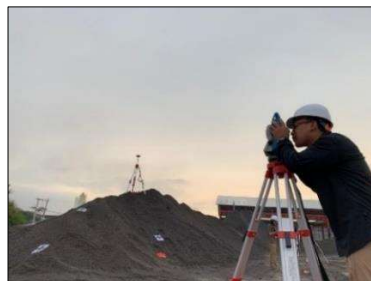
Gambar 4.5. Pengukuran dengan menggunakan Total Station
