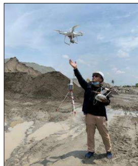
Gambar 4.7. Pengukuran dengan UAV
