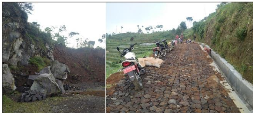
Gambar 4.43 Penambangan batuan basalt yang dimanfaatkan sebagai pembuatan jalan dan sebagainya.
