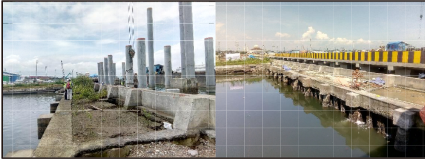
Gambar 2. Kenampakan coffer dam yang diteliti.
