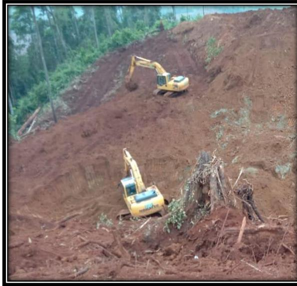
Gambar 2.6 Pengupasan Tanah Penutup
