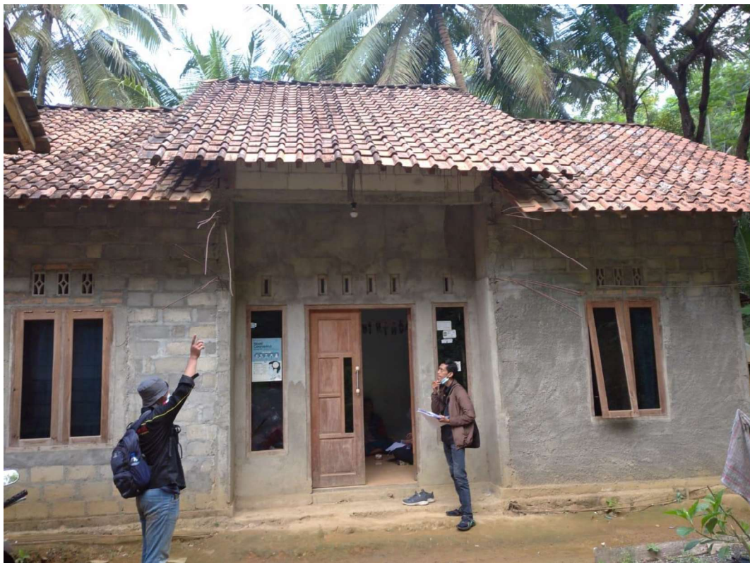
Gambar 1. 4 Kondisi Bangunan Existing
