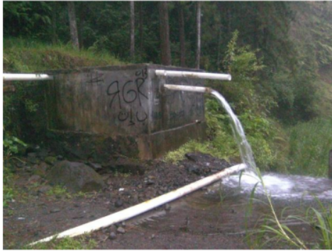
Gambar 5. Bangunan penangkap air dari Umbul Wadon di hulu K. Kuning, Sleman (kiri) dan reservoir Jambu Dusun Dringo, Girijati, Purwosari, Gunungkidul (kanan).
