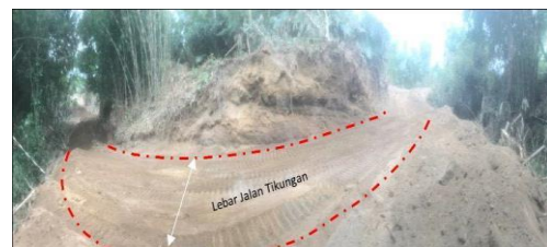
Gambar 2. Lebar jalan aktual pada jalan menikung
