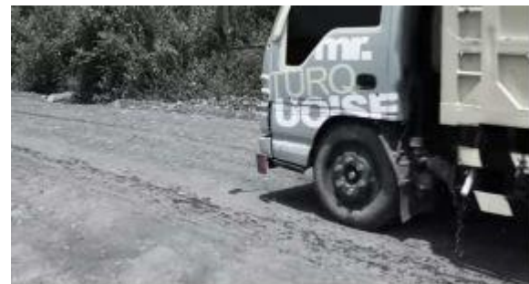
Gambar 4. Kondisi jalan angkut yang tidak memiliki paritan
