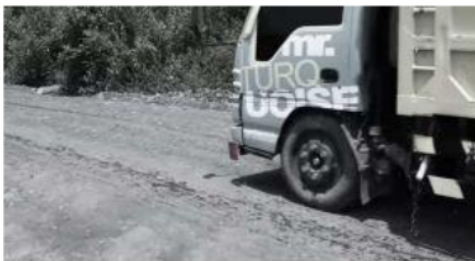
Gambar 3. Kondisi jalan angkut yang tidak memiliki paritan
