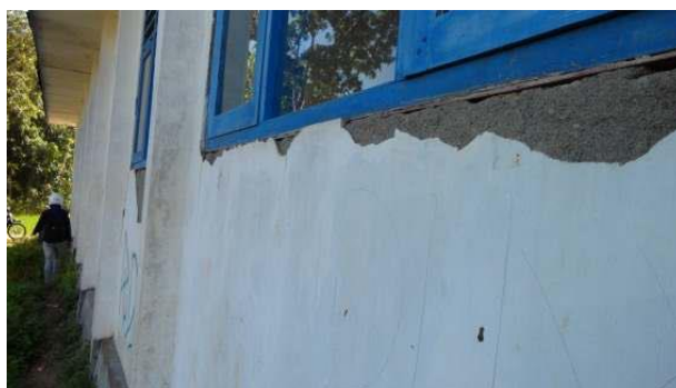
Gambar 3. Kondisi Eksisting Bangunan
