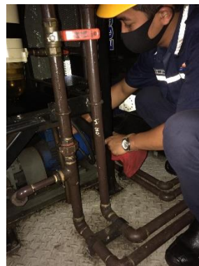
Gambar 1. 16 Memeriksa Pompa Bahan Bakar Elektrik Dan Manual
