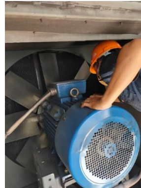
Gambar 3. 8 Pemeriksaan Motor Fan Radiator
