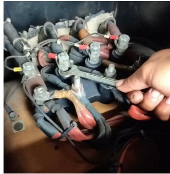
Gambar 8. 7 Memeriksa Mur Baut Pada Terminal Generator
