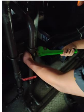
Gambar 1. 14 Pemeriksaan Sambungan Pipa
