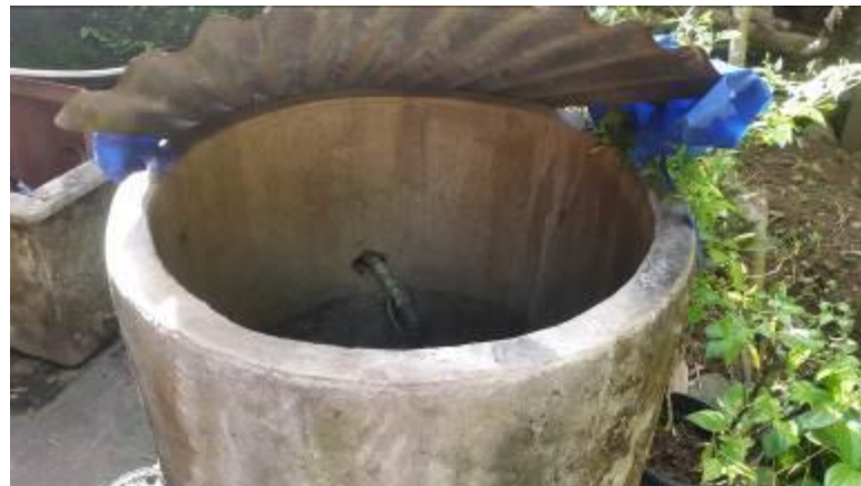
Gambar 5.6. Sumur gali di Karang (Gerbosari), kedalaman muka airtanah mencapai 17 m dpt (LP M25; Foto M.4.6).
