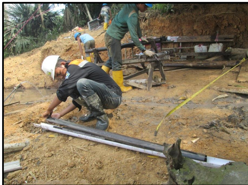
Gambar F.2 Mengeluarkan Core Dari Skid Core Barrel
